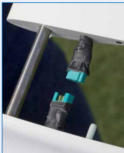
Hochstromleitung: drei Servos (QR, WK und LK) wollen mit Strom versorgt werden
